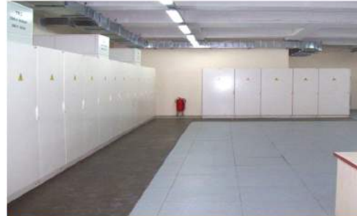
MV Metal Clad Switchgears
