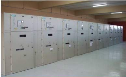
34.5 KV Metal Clad Switchgears
