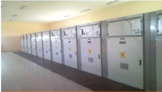
34.5 KV Metal Clad Switchgear
